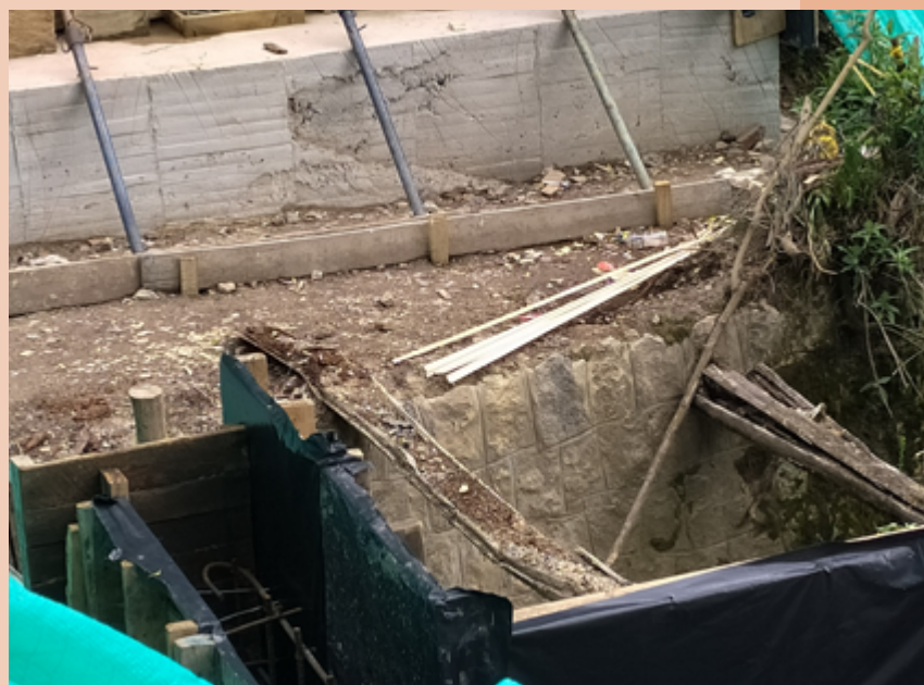
Foto: Ana María Gómez. Antigua estructura del puente en piedra. Año 2020
