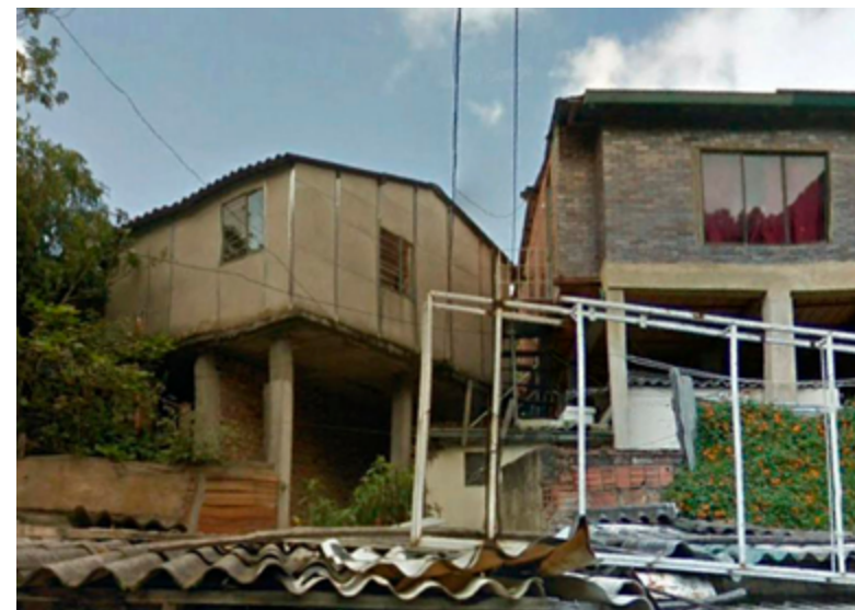
Foto: Ana María Gómez, año 2020. Detalle de viviendas elevadas sobre pilares esbeltos como zancos.
